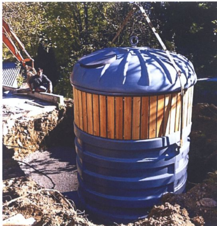
1) Contenitore seminterrato per vetro, in fase di posa - rivestimento in legno
