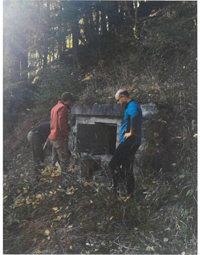
Camera della vasca bassa attualmente in servizio
